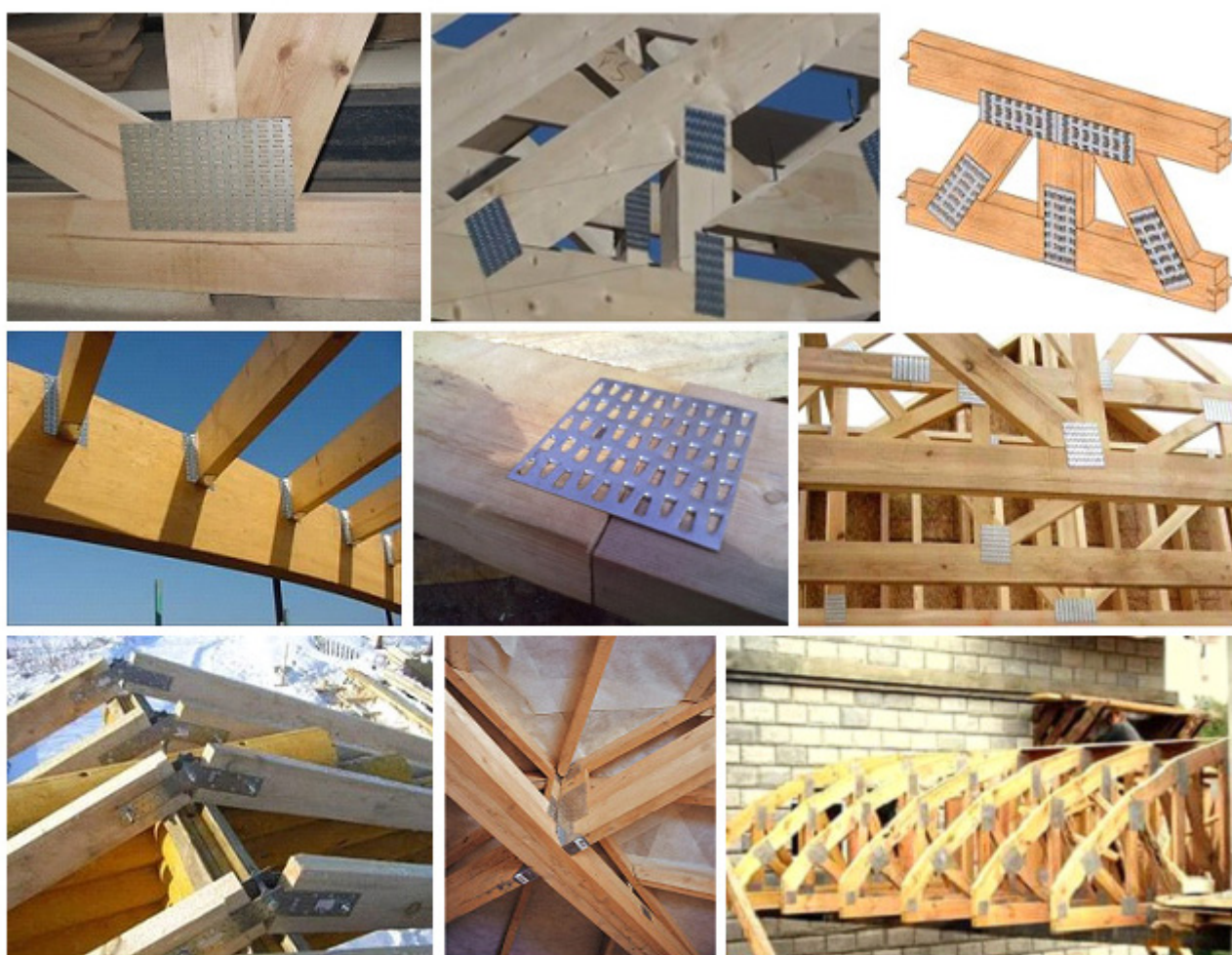
Фото 2. Узлы и конструкции с применением МЗП
